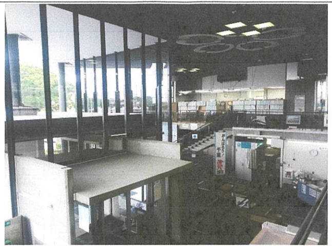
市役所ロビー吹き抜け
